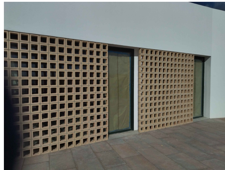
IMAGEN DE LA OFICINA-ALMACÉN
