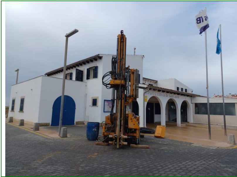
Emplazamiento de la máquina en el punto de sondeo S-1
