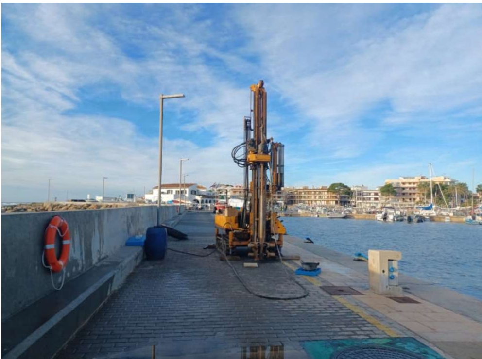
Figura 7.- Maquinaria ejecutando sondeos en dique.
