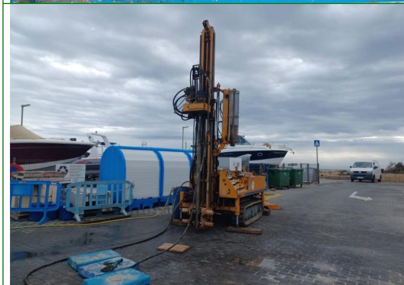
Emplazamiento de la máquina en el punto S-2
