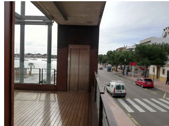
13. ACCESO A PLTA. 1ª ASCENSOR
