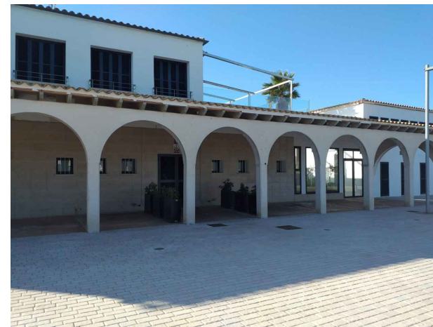
I4. FACHADA POSTERIOR
