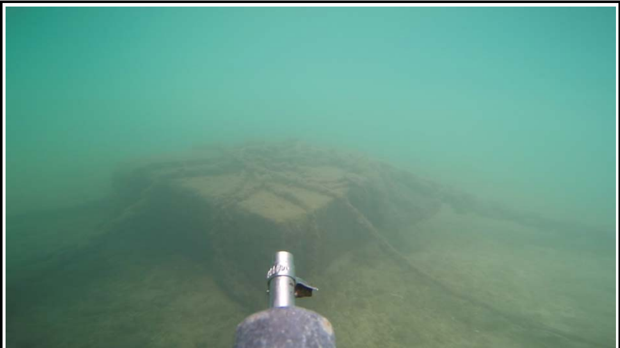
Figura 21.- Detalle de muertos de hormigón, cabos y cadenas localizados frente al dique sur del puerto de Andratx.
