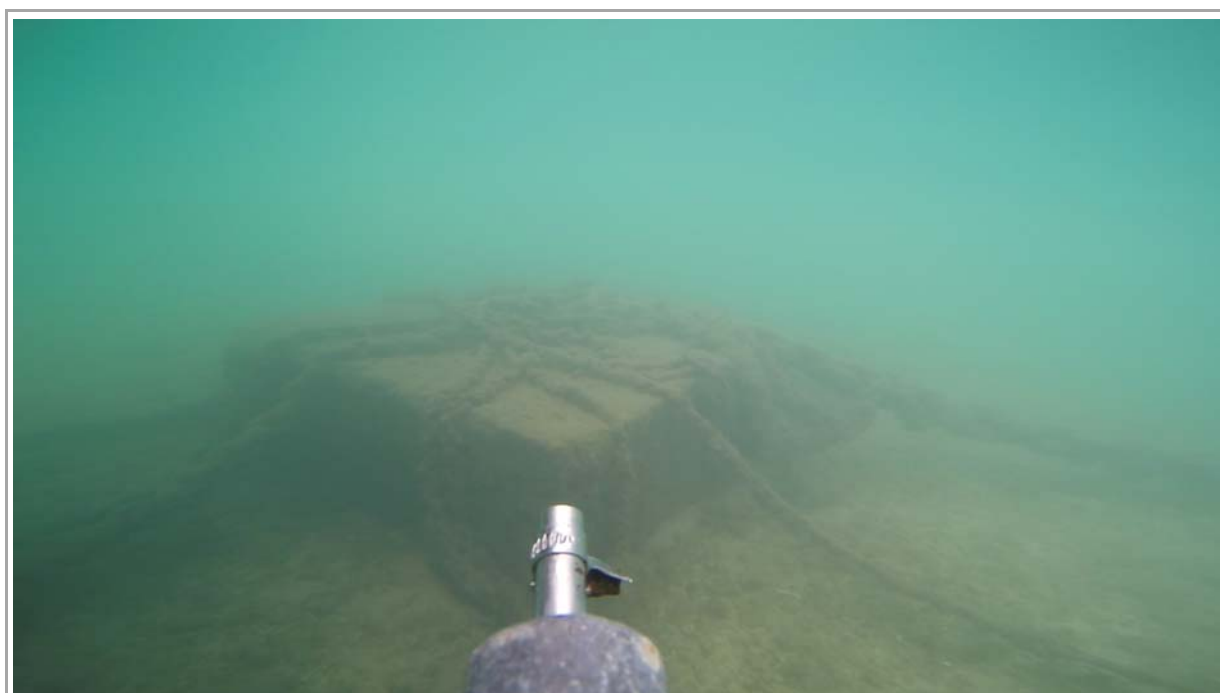
Figura 30.- Sustrato rocoso artificial (muerto de hormigón) localizado en distintos puntos de la zona de prospección.
