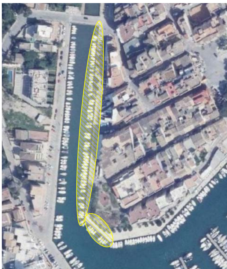
Foto 1. Vista aérea de la zona. Marcada en amarillo los tramos de cantil afectado
